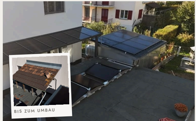
VOM ZIEGELDACH ZUR DACHFLÄCHE, DIE STROM MACHT
